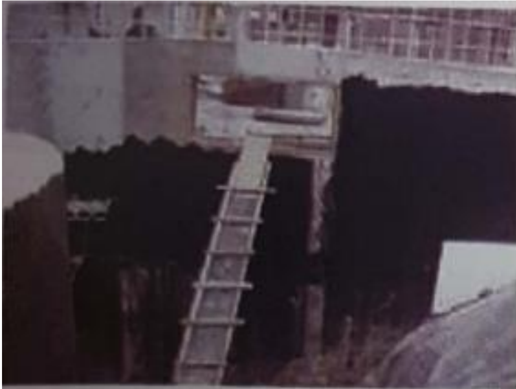
Tangga yang tidak selamat
